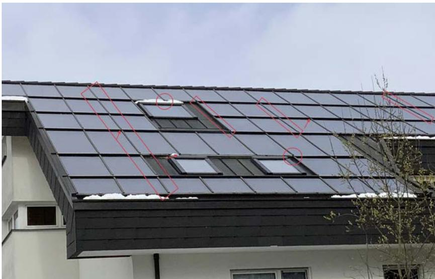
Ein weiteres Gutachtenthema: Die Solarthermieanlage auf einem Mehrfamilienhaus weist Undichtigkeiten/Mängel in der handwerklichen Anbringung der Kollektoren auf dem Dach auf. Das führte zu eindringendem Wasser im Dach. Es entstand ein erheblicher Wasserschaden an der Dachkonstruktion und in der Dachgeschosswohnung.
